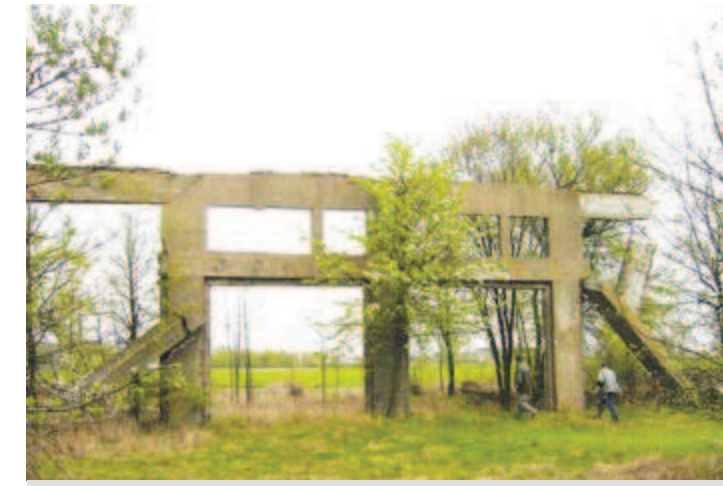
Poniemieckie konstrukcje w okolicach Wolanowa.
